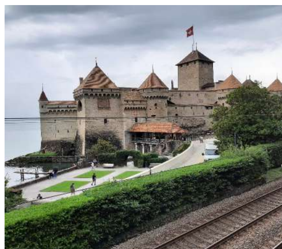
Château médiéval de Chillon -restauration XIXe -sept. 2022
